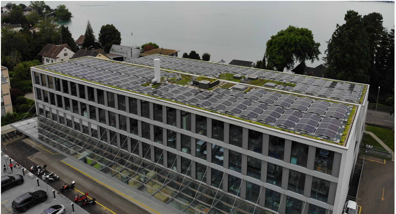
Installation photovoltaïque sur l'immeuble commercial sur la Seestrasse à Männedorf/ZH
